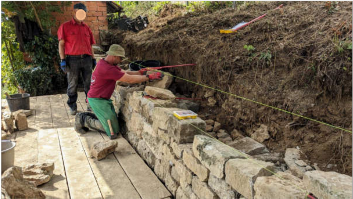
Abb. 5: Beim Trockenmauer-Sanierungskurs der LVG wird man auch individuell betreut. Hier zeigt ein Mitarbeiter des Teams von Martin Bücheler einem Teilnehmer wie der Stein vor dem Setzen optimal in Form und Position gebracht wird.
