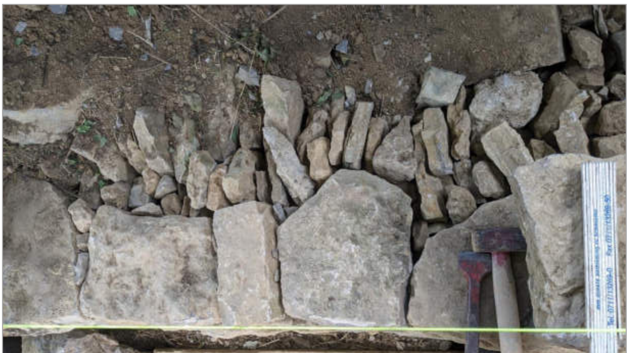
Abb. 6: Nach dem kraft- und formschlüssigen Setzen der Mauersteine, werden vertikal gelagerte kleinere Steine für die Hintermauerung eingesetzt bzw. sanft eingeklopft..
