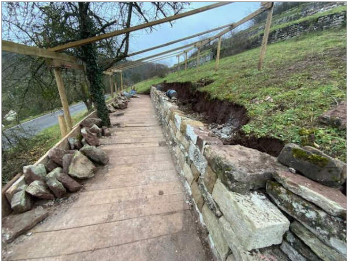
Abb. 34: Die Trockenmauer-Sanierungsbaustelle kurz vor der Abnahme. Hier wird, nachdem die Mauerkrone vollendet wurde noch das Erdmaterial nachgefüllt.
