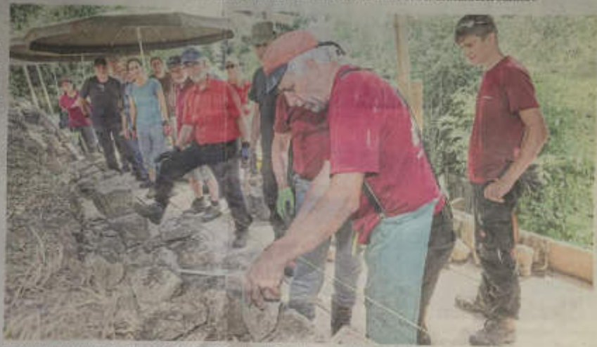
Trockenmauern bauen und sanieren ist harte Handwerkskunst, die Gartenbaumeister Martin Bücheler beibringt.
