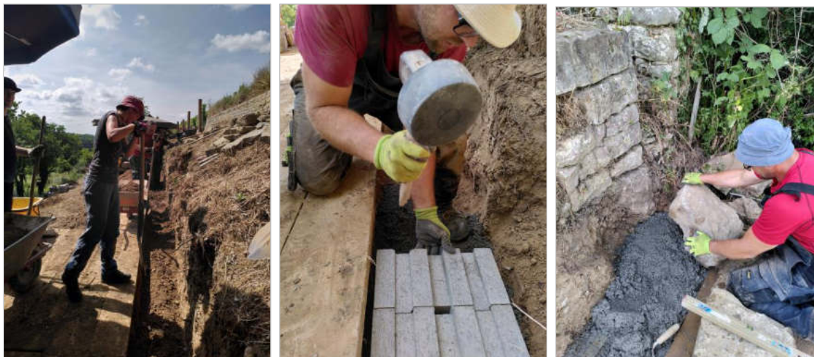
Abb. 6, 7 und 8: Vom Ausgraben des Fundaments bis zur Ecksteinlegung.
