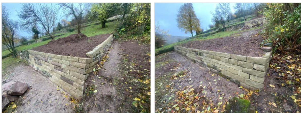
Abb. 32 und 33: Backenmauern nach der Sanierung, deren umgebende Fläche durch einen LPR-A-Vertrag gepflegt wird
