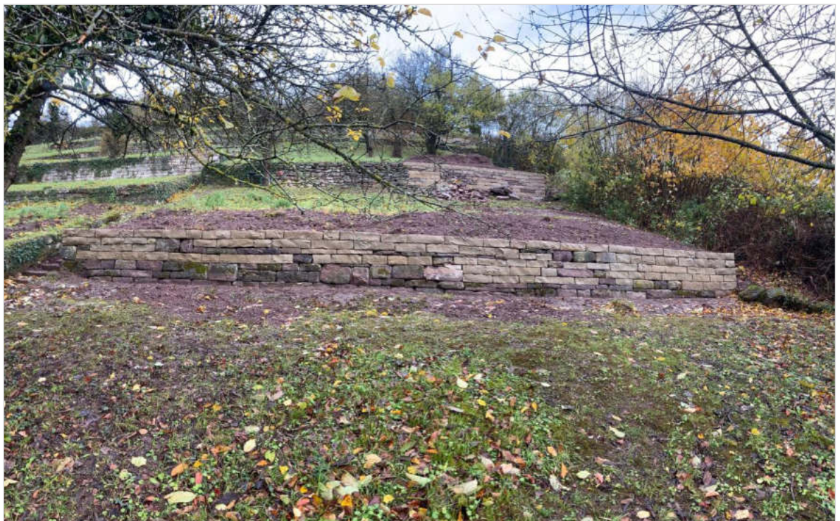
Abb. 35: Nach der Sanierung die wiederhergestellten Sanierungsabschnitte im Herbst 2023
