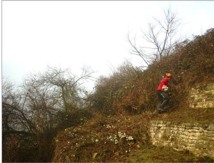
Abb. 2: Entbuschungsarbeiten an der Roßwager Halde
